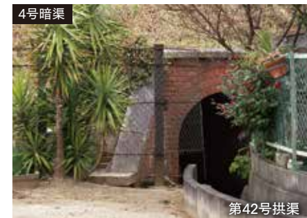
4号暗渠 第42号拱渠 狭山里道暗渠と狭山里道架道橋の間の住宅地に隠れてひっそり存在する拱渠。もっぱら水路用として用いられている。くぐり抜け不可能。
