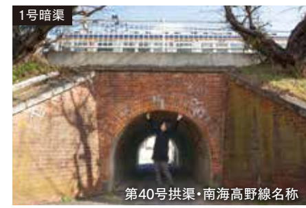
1号暗渠 第40号拱渠・南海高野線名称 レンガの積み方はアーチ部分長手積、他は側壁、抗門、翼壁ともにイギリス積み。
