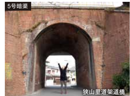
5号暗渠 狭山里道架道橋 径間6.10m(20フィート)の堂々たる架道橋で高野線全線を通じて最大のアーチ構造物で、空頭を確保するため欠円アーチを採用。アーチ端部のレンガは5枚巻と厚くなっている。
