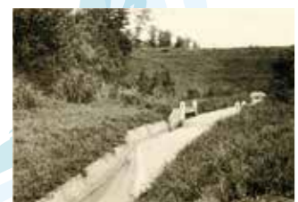
第二狭山池樋管水量堰『狭山池改修誌』
