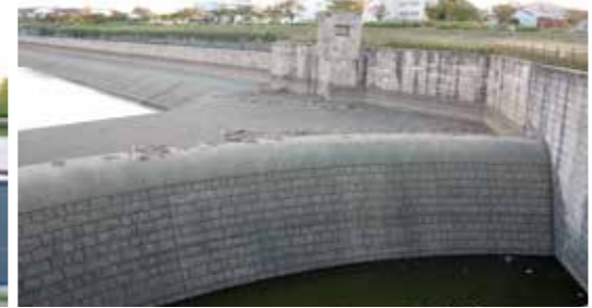
狭山池の第二取水施設
