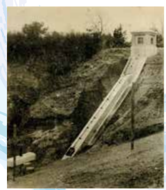
第二狭山池樋管『狭山池改修誌』
